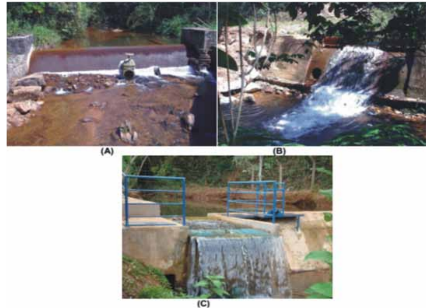
Pontos de Captação no Município de Itabirito Fonte: SAAE Itabirito
