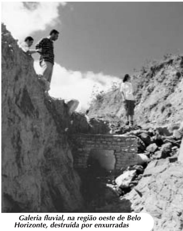
**Galeria fluvial, na região oeste de Belo Horizonte, destruída por enxurradas**
