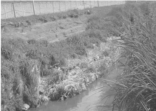
Colapso da parede em gabião do Córrego da Ressaca
