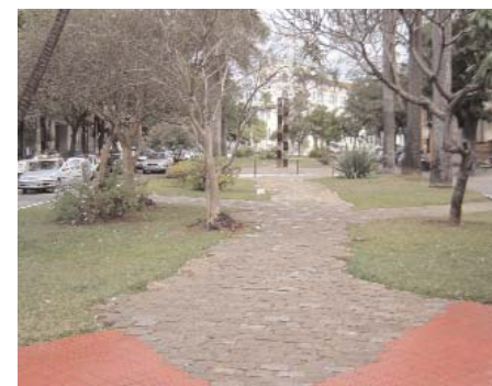
Canteiro central serve de "janela de infiltração"
