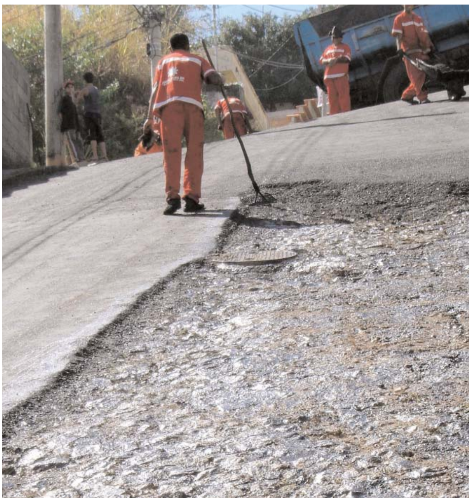
Rua com calçamento de pedras fincadas recebe asfalto, que aumenta velocidade da água
