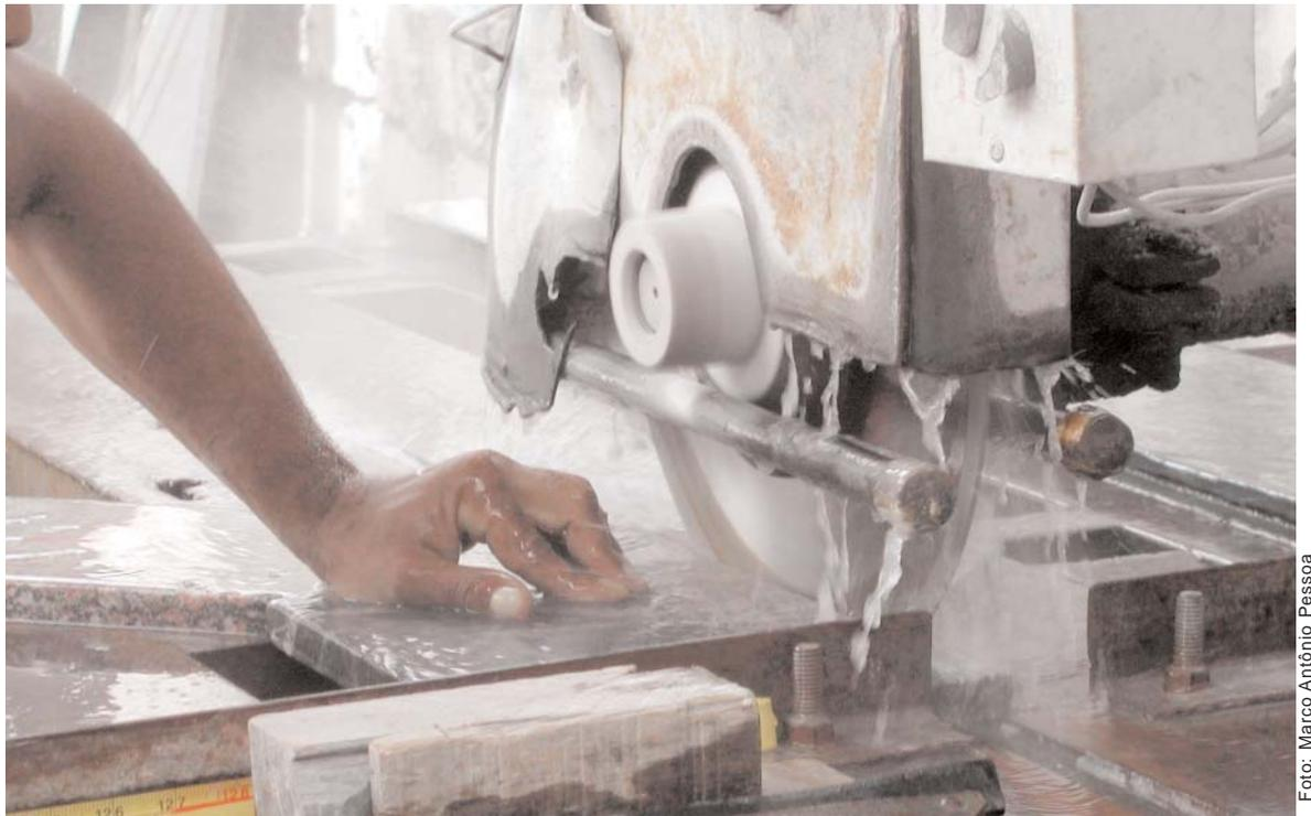
Processos como o corte de granito devem ser feitos com a utilização de água para evitar a dispersão do pó de sílica
