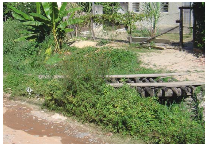
Trecho do córrego N. S. da Piedade, que será transformado em parque
