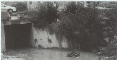
Córrego Tamboril, que já foi navegável e área de lazer, hoje é puro esgoto e fonte de doenças
