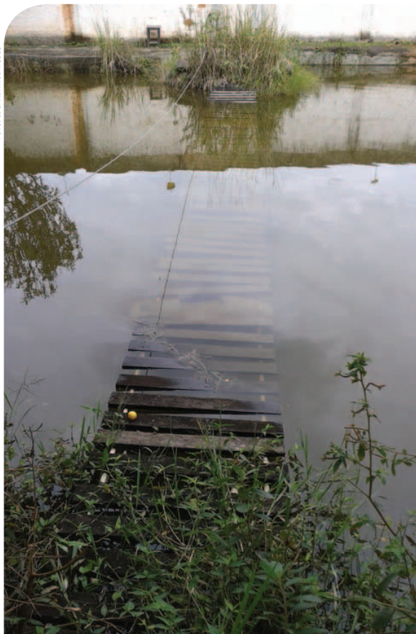
Açude construído por moradores do bairro Céu Azul, na região norte de BH, aproveita o potencial hídrico da região
