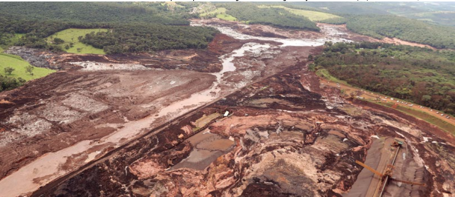
Área afetada pelo rompimento da barragem da mina Córrego do Feijão em Brumadinho (MG) Foto: Andre Penner/AP
