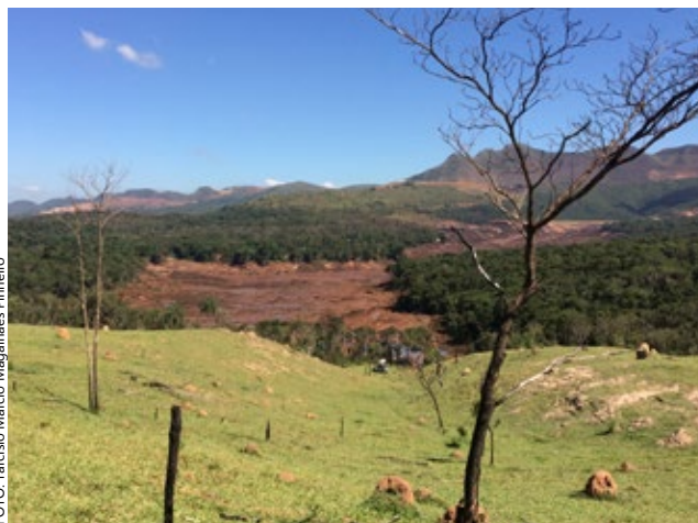
FOTO: Tarcísio Márcio Magalhães Pinheiro Ruptura da barragem B1 da Vale, no córrego do Feijão, em Brumadinho.
