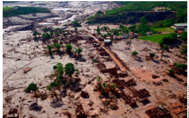
Rompimento da barragem de Fundão da Samarco, Mariana - MG.
