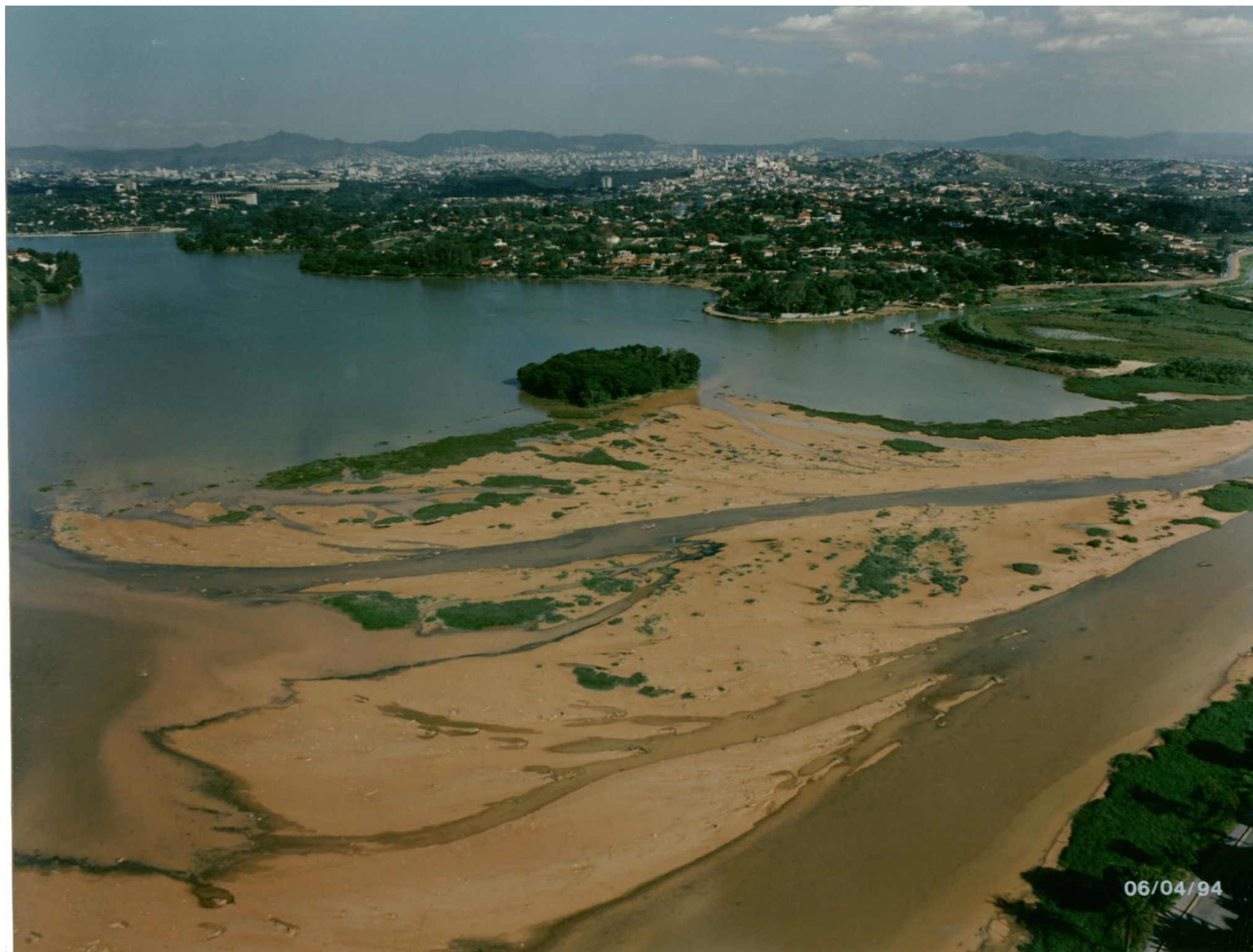
Fig. 03- Foto aérea do processo de assoreamento que já comprometeu mais de 30% da superfície original da represa (SUDECAP).
