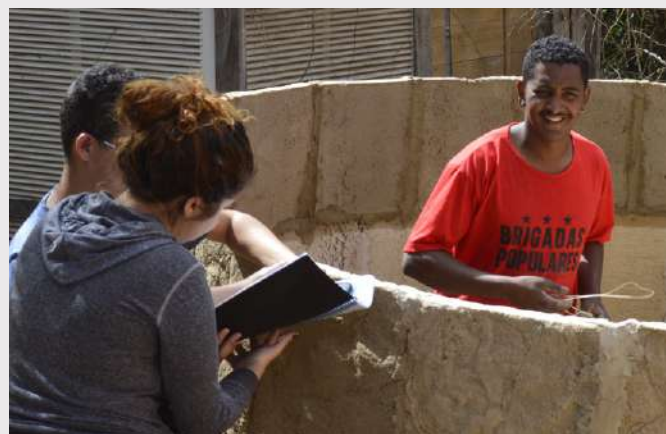
Processo de construção na cozinha solidária da Ocupação Vitória.
