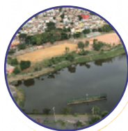
3 Barragem Santa Lúcia (bacia de detenção)
