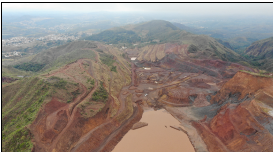
Figura 2 - Imagem de drone ANM - Visão da mina de montante para jusante, detalhe das áreas já em recuperação na porção inferior da mina e degradação na porção superior. Vista dos samp's ao longo do talvegue principal.
